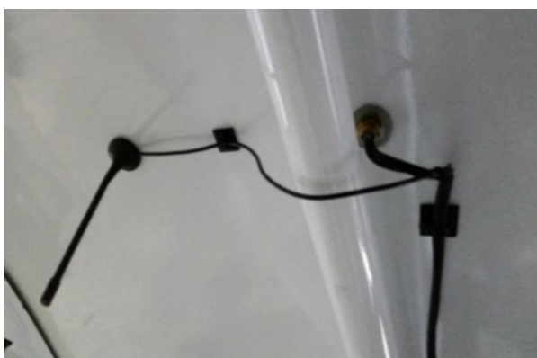
Bild 14: Montage WiFi-Antenne Dach-innenseite
